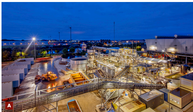
A Installatie Alkmaar
