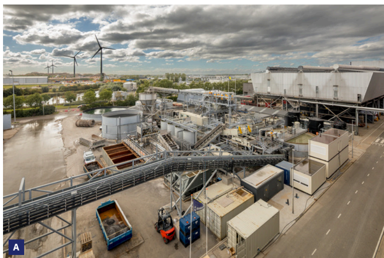
A. WASH plant bij HVC Alkmaar
