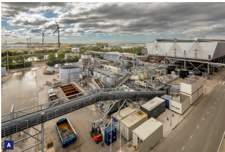
A WASH plant bij HVC Alkmaar
