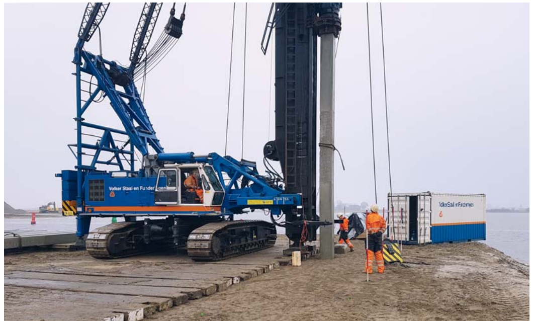
Figuur 11 – Installatie prefab betonpalen vierkant 450 vanaf werkeiland bij het benedenhoofd (15-2-2018).
