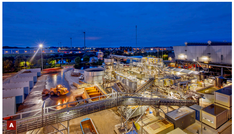
A Installatie Alkmaar B Kwaliteitscontrole in het werk
