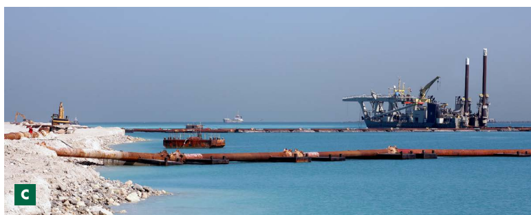
C Equipamento 'Phoenix' a bombear material para aterro
